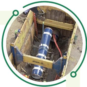
**70** Tubería subterránea de **112 kilómetros de largo** y 107 centímetros
