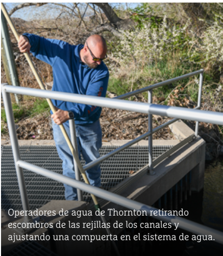
Operadores de agua de Thornton retirando escombros de las rejillas de los canales y ajustando una compuerta en el sistema de agua.
